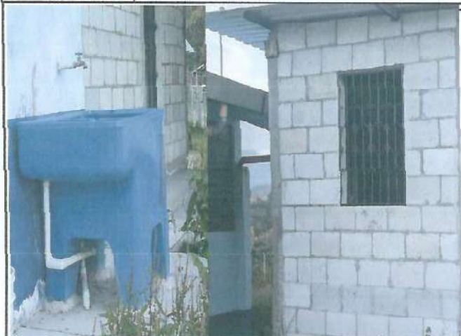
Foto 1: MEJORAMIENTO EN ÁREA DE COCINA, DEPÓSITO DE AGUA Y PILA
