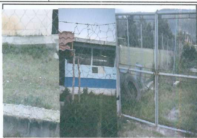
Foto 2: MEJORAMIENTO DE CERCAMIENTO PERIMETRAL Y PORTÓN DE INGRESO.
